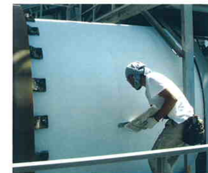
ドライヤーの外壁をコテ塗り
