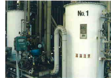
放熱防止、劣化防止
