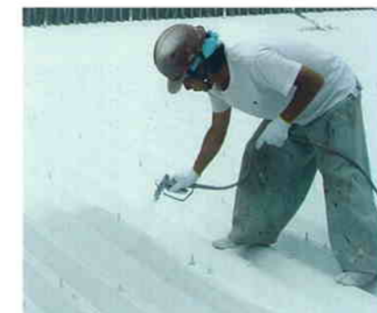
屋根をスプレー塗り
