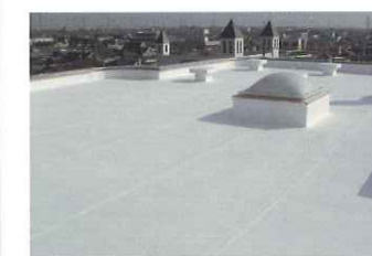
マンション 屋上
