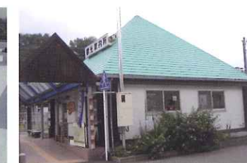
観光案内所 屋根・外壁
